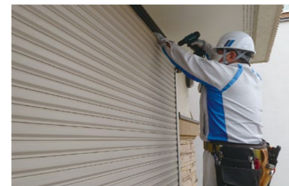
YKK APメンテナンス認定技能士によるシャッターのメンテナンス
