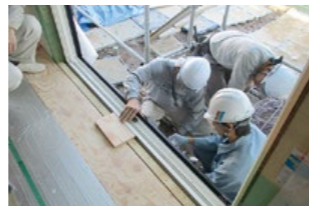
「APW」施工研修
