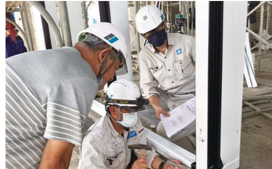
台湾での現場施工研修
