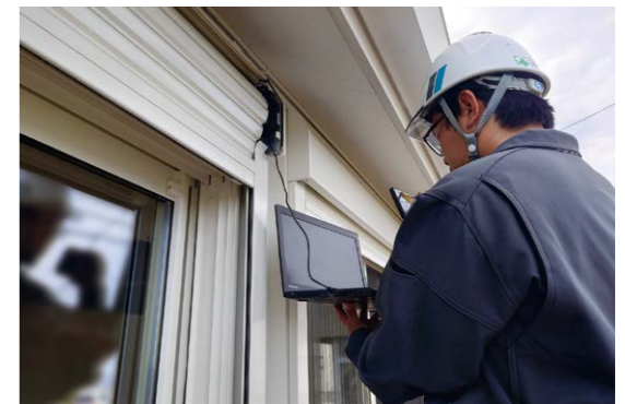
デジタルツールを使用した電装商品のメンテナンス
