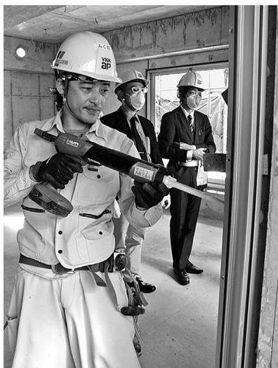
非溶接工法でビルサッシを施工
