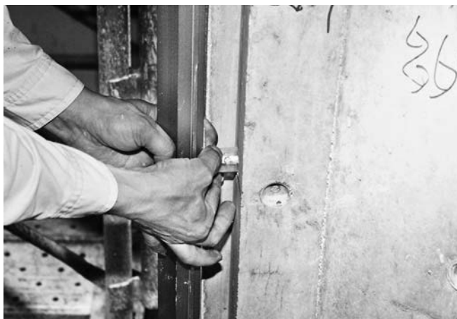
躯体にピンを打ち込んで窓側部品を取り付け、 高強度樹脂材を充てんして固定
