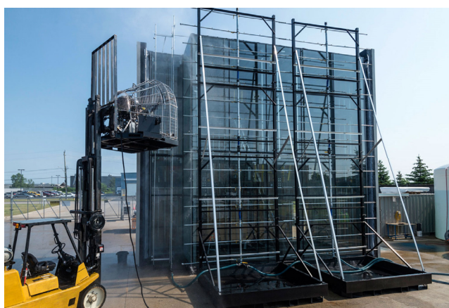
エリーAP社、ユニットカーテンウォール性能検証の様子
