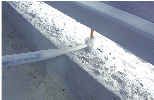
専用アンカー内に樹脂剤を注入するだけ
