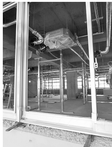
非溶接工法で取り付けしたサッシ
